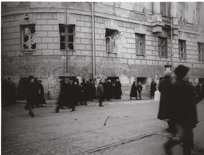
Рис. 2. Повреждённое при обстреле здание Московского университета в ноябре 1917 г. Автор фото неизвестен. Источник: https://russiainphoto.ru/photos/145970/
